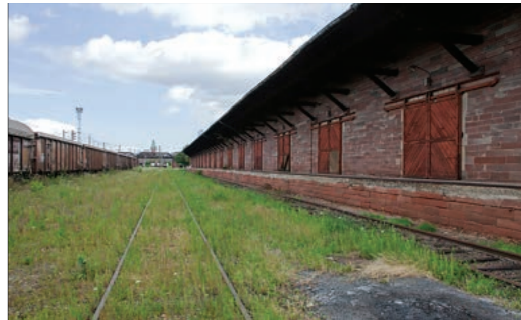
La grande halle fret de l'ancienne gare de marchandises de Colmar. © Christophe Hamm, Région Grand Est, Inventaire général.
